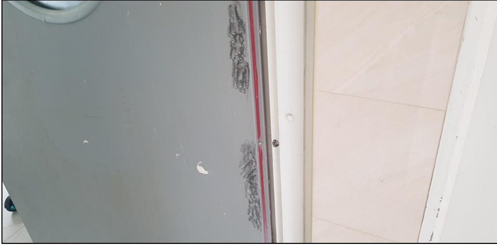
2.31 היעדר גמר טיח חדר חשמל + צבע כללי, נדרש לסיים גמר עבודות בחדר החשמל.
