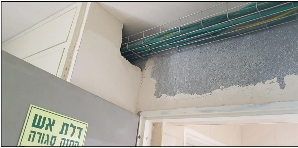
2.31 היעדר גמר טיח חדר חשמל + צבע כללי, נדרש לסיים גמר עבודות בחדר החשמל.
